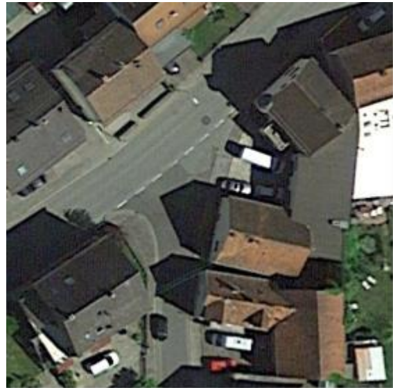
Abb. 1: Immens große Eckausrundung erhöht die zu querende Distanz für Fußgänger auf über 20 Meter (in Schwedelbach)
