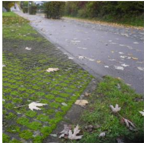
Abb. 8: Als Bankett geeigneter, kleinteiliger und rechteckiger Rasengitterstein
