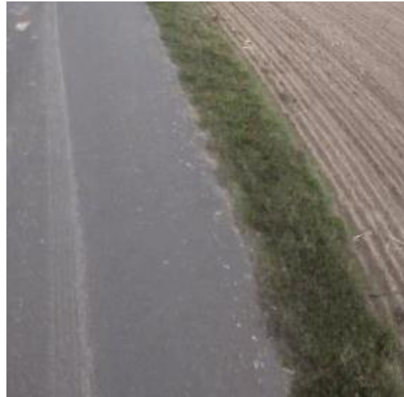
Abb. 17: Grünstreifen unterbinden das Ausspülen von Sand durch Regen
