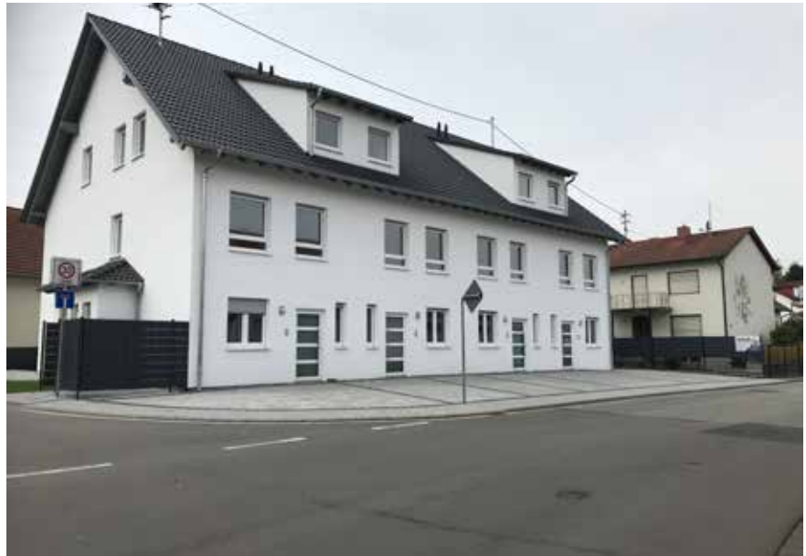
Negativ ortsbildprägendes Gebäude in der Hauptstraße
