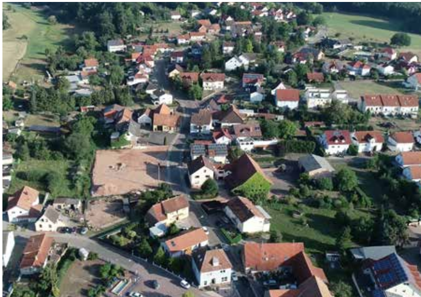
Ausschnitt der Drohnenaufnahme mit Blick auf die Bebauung der Kollweilerstraße
