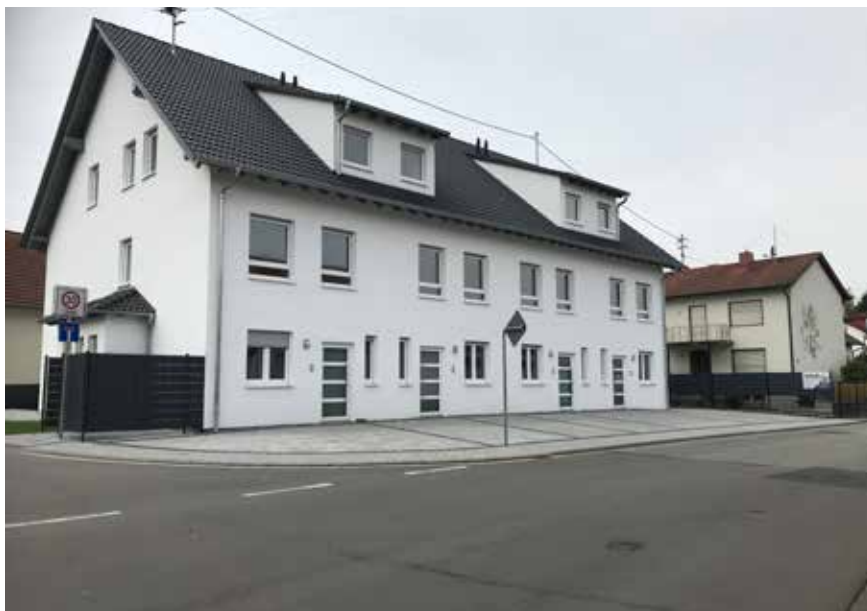
Negativ ortsbildprägendes Gebäude in der Hauptstraße
