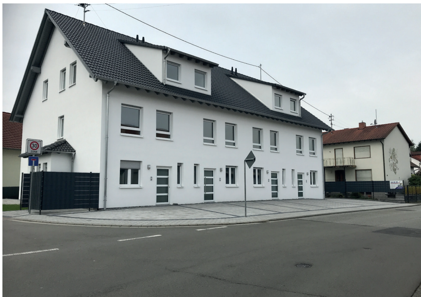
Negativ ortsbildprägendes Gebäude in der Hauptstraße
