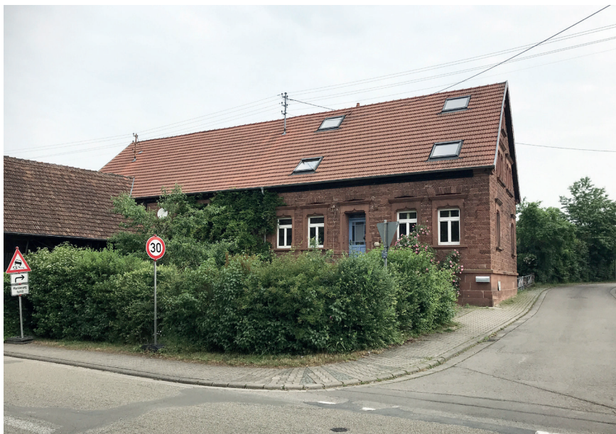
Positiv ortsbildprägendes und denkmalgeschütztes Gebäude in der Hauptstraße
