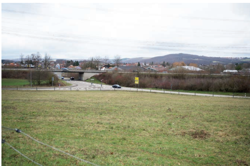
Blick Richtung Nordwesten auf den an das Plangebiet angrenzenden Kreuzungsbereich der Kreisstraße 13 und 25 (K 13 / K 25) im Bild
