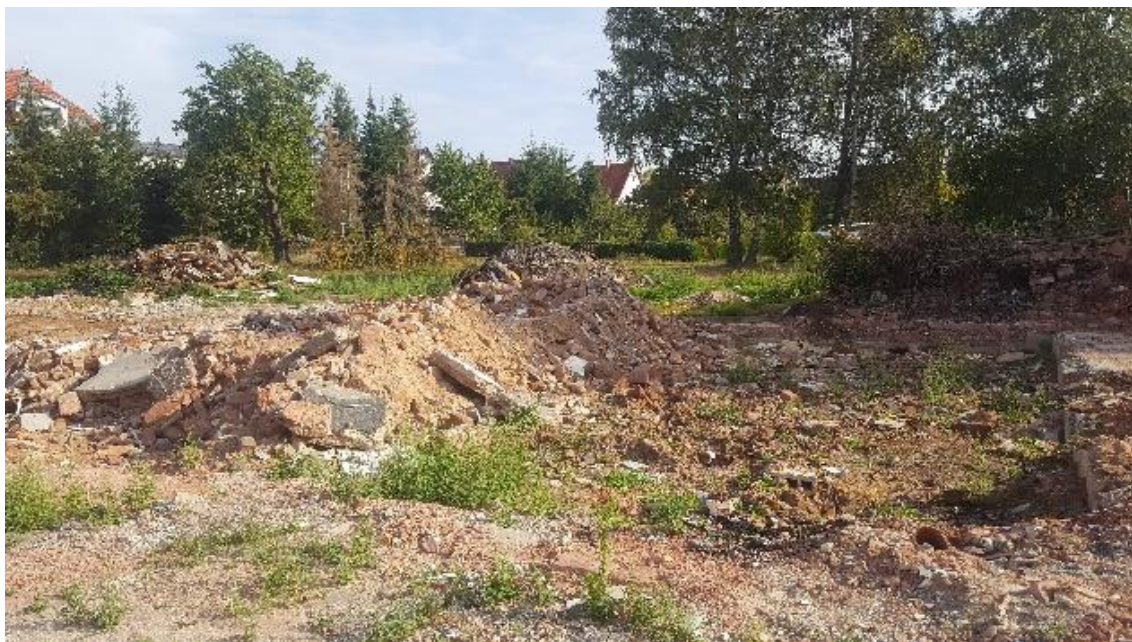
Bereich des abgerissenen Gebäudes „Hinter der Kirche“ (BBP 09/2020)
