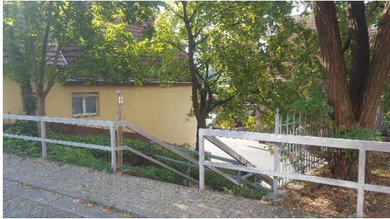
Verbindungsstreppe zwischen Hauptstraße und Schulhübel
