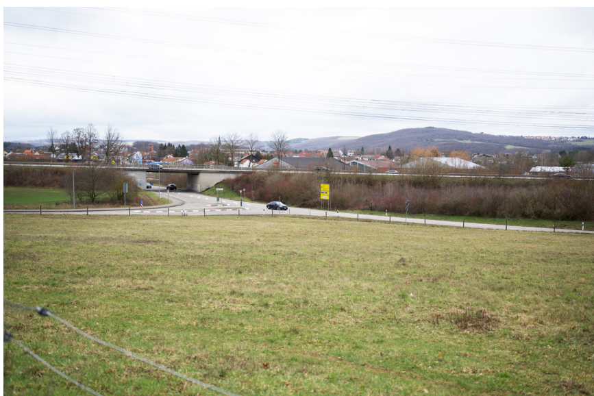
Blick Richtung Nordwesten auf den an das Plangebiet angrenzenden Kreuzungsbereich der Kreisstraße 13 und 25 (K 13 / K 25) im Bild
