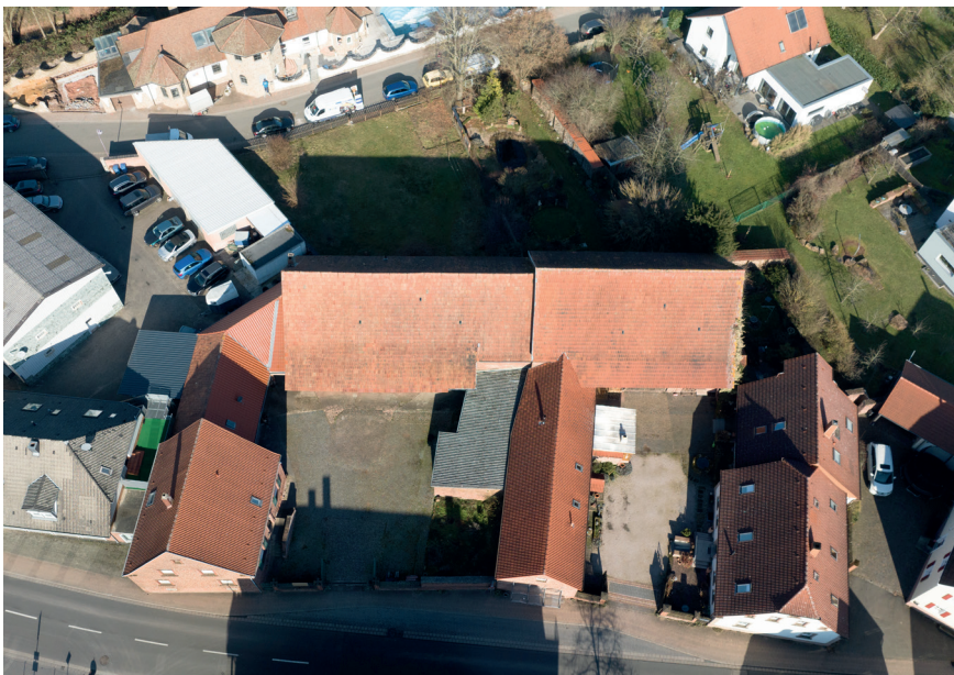
Drohnenaufnahme ortsbildprägende Haus-Hof-Bauweise im Ortskern Rodenbach
