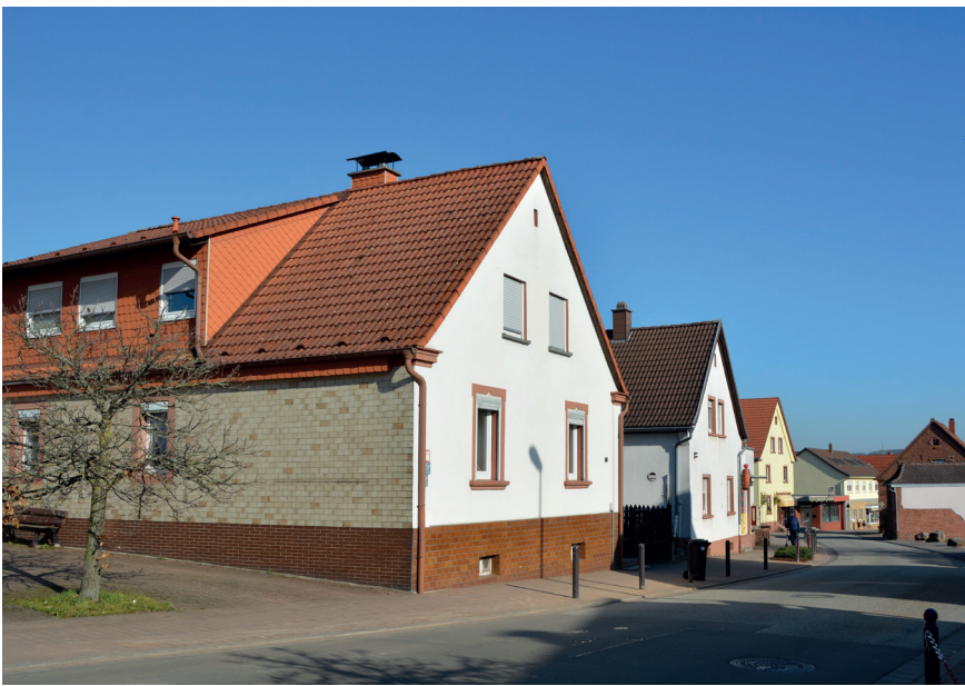
Prägende Straßenrandbebauung im Bereich der Hauptstraße
