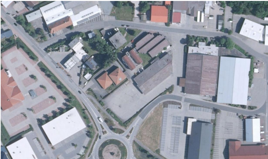
Luftaufnahme des Plangebietes mit Umfeld vom 17.05.2020 Quelle: LANIS RLP 09/2023
